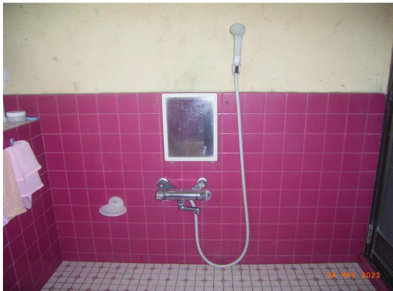
■現状写真■ (工事施工前)
