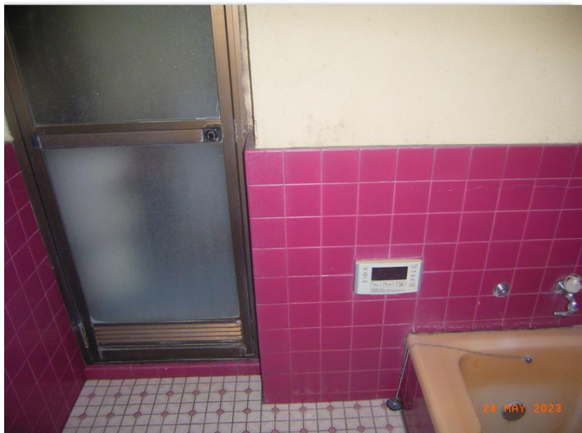
■現状写真■ (工事施工前)
