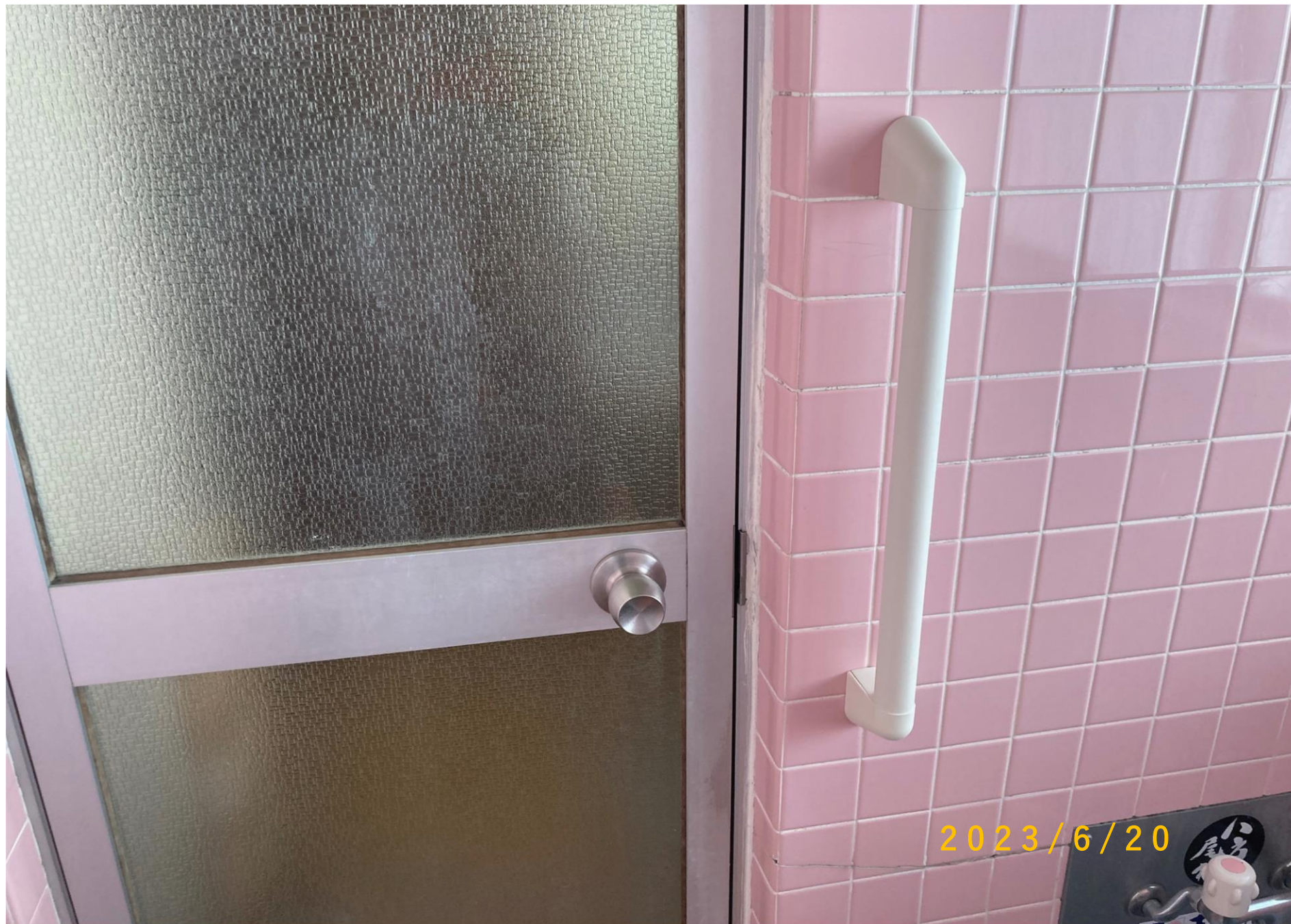
完成写真⑤ 浴室 手すり
