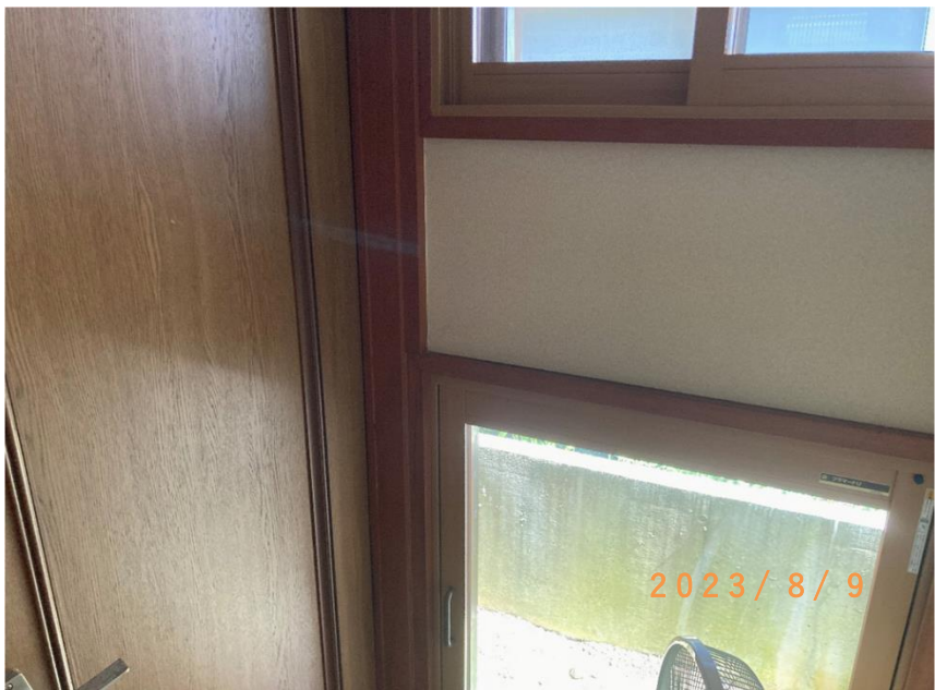
■現状写真■ (工事施工前)
