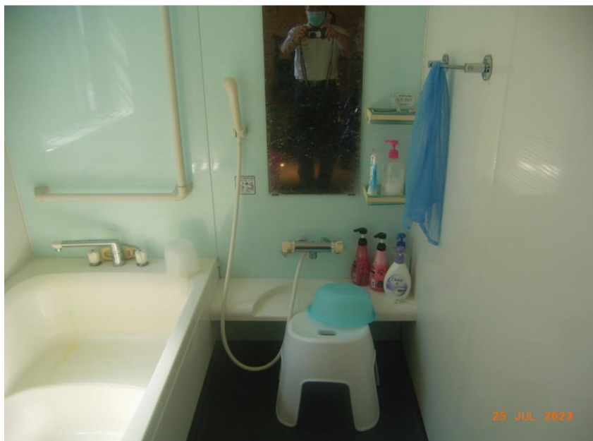
■現状写真■ (工事施工前)
