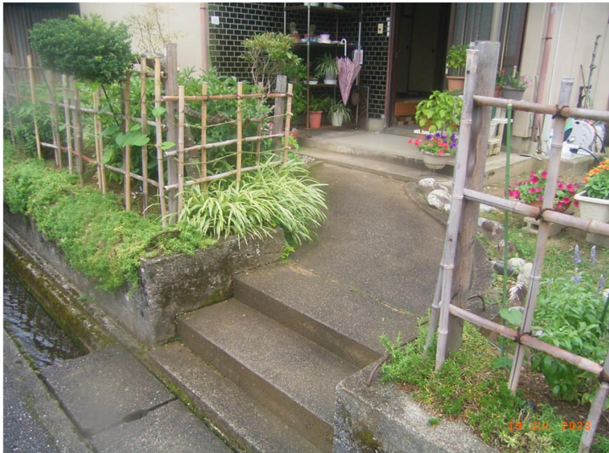
■現状写真■ (工事施工前)
