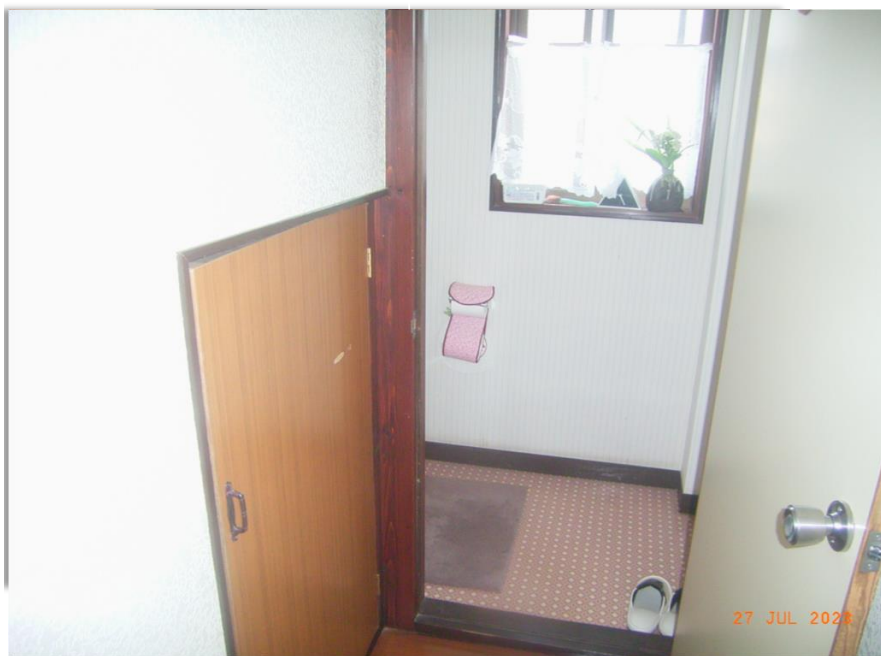
■現状写真■ (工事施工前)
