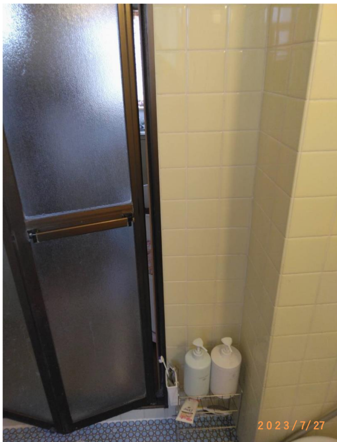
■現状写真■ (工事施工前)
