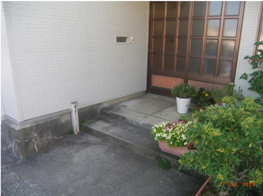
■現状写真■ (工事施工前)
