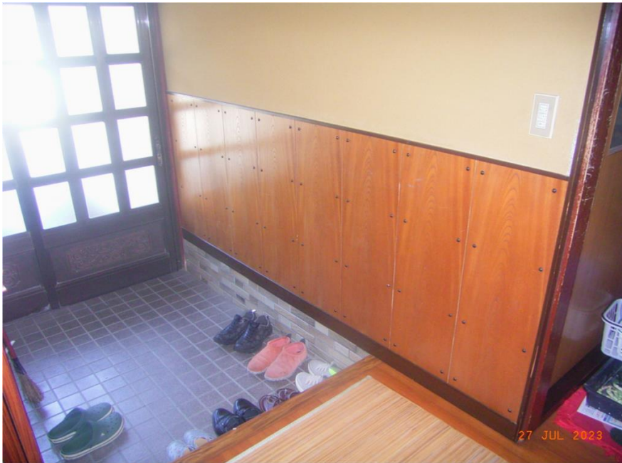
■現状写真■ (工事施工前)
