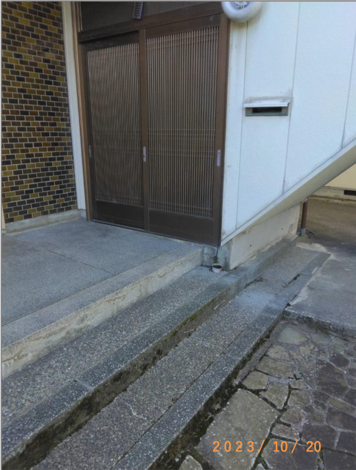
■現状写真■ (工事施工前)
