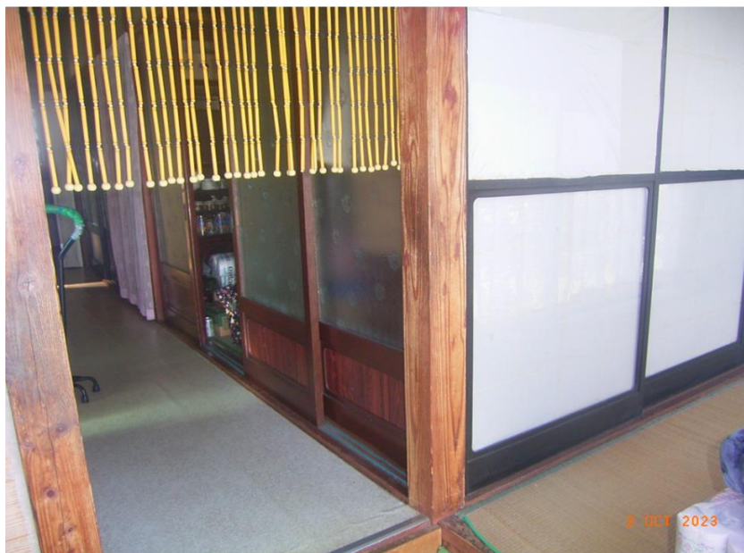
■現状写真■ (工事施工前)
