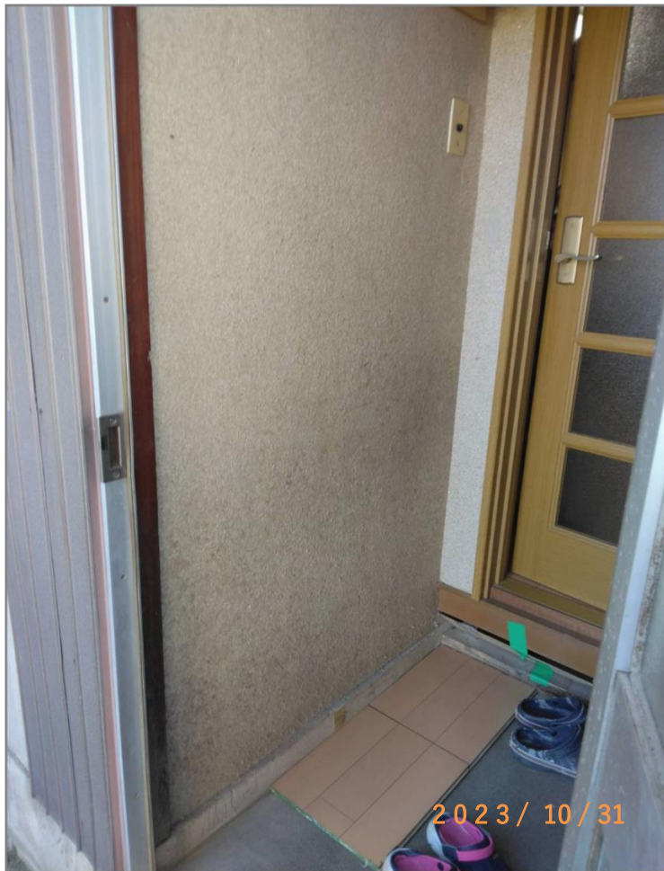
■現状写真■ (工事施工前)
