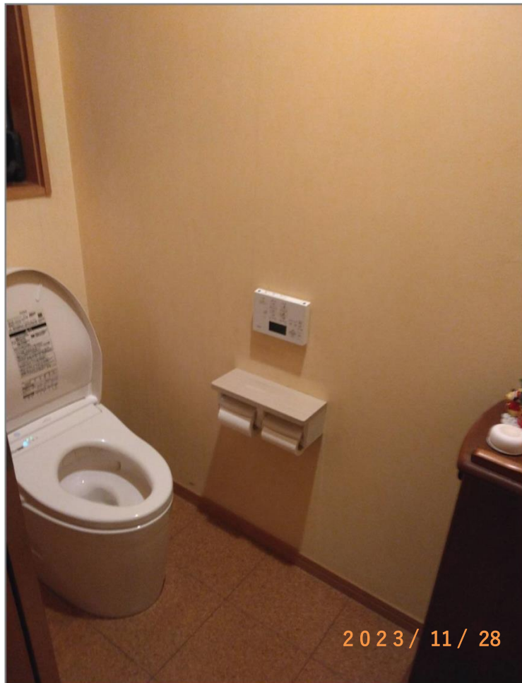
■現状写真■ (工事施工前)
