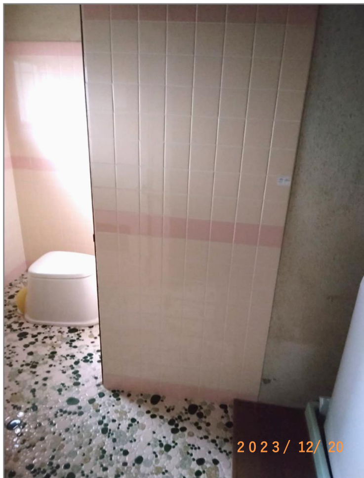
■現状写真■ (工事施工前)
