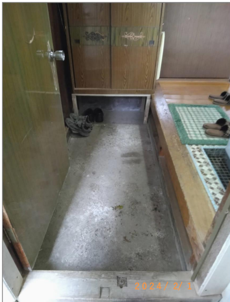
■現状写真■ (工事施工前)
