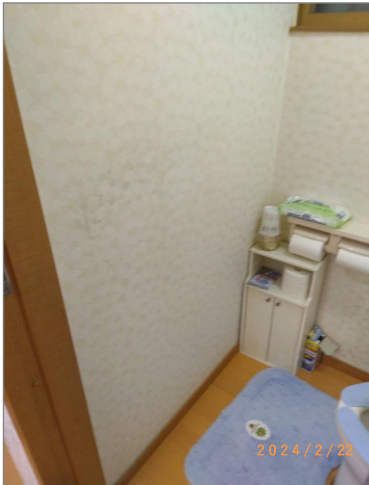
■現状写真■ (工事施工前)
