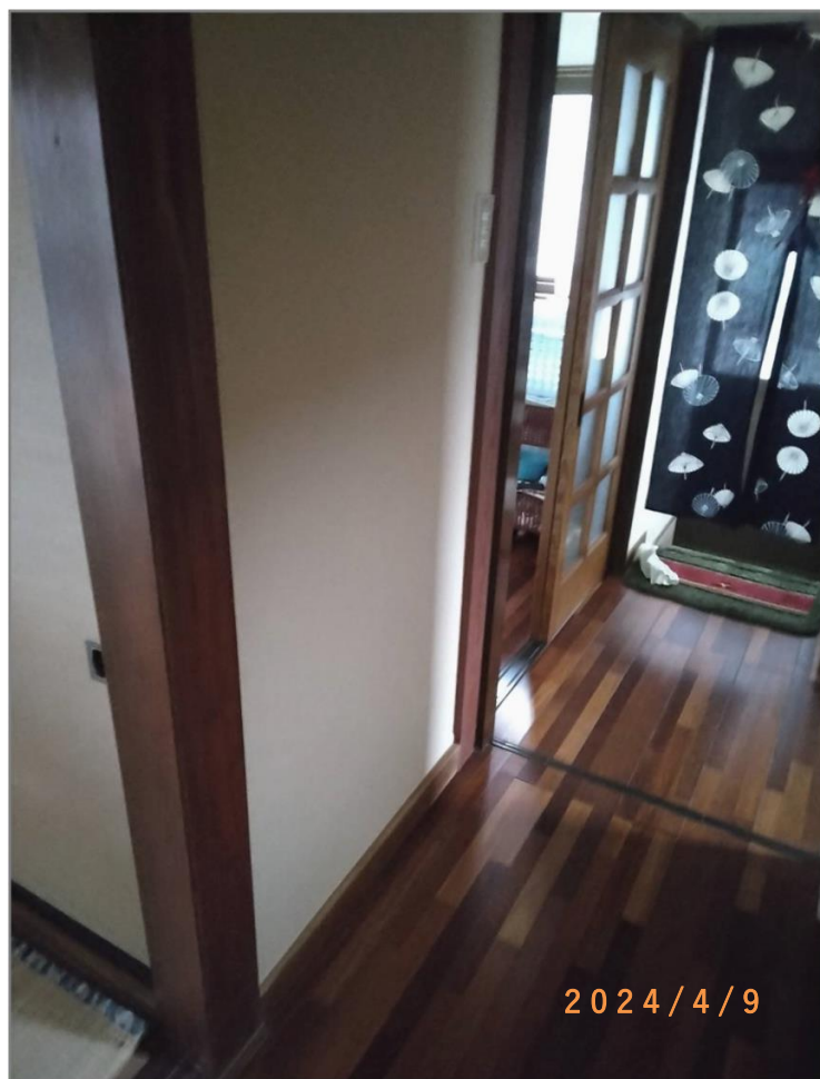
■現状写真■ (工事施工前)
