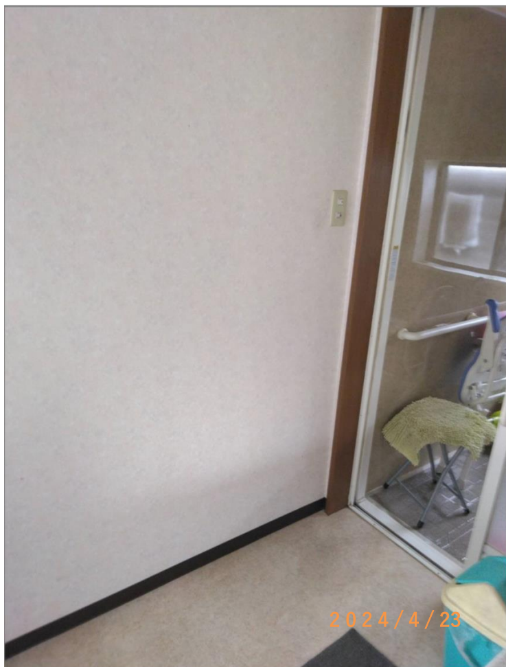
■現状写真■ (工事施工前)
