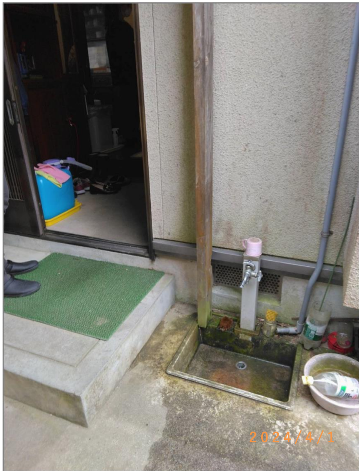
■現状写真■ (工事施工前)
