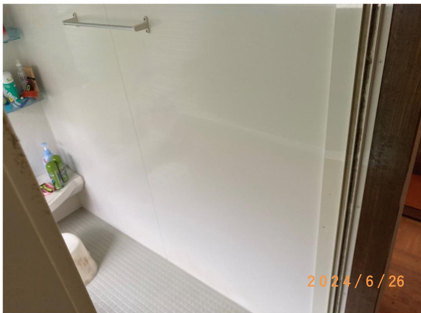
■現状写真■ (工事施工前)
