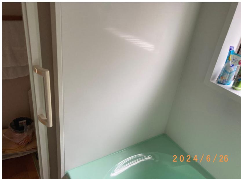
■現状写真■ (工事施工前)
