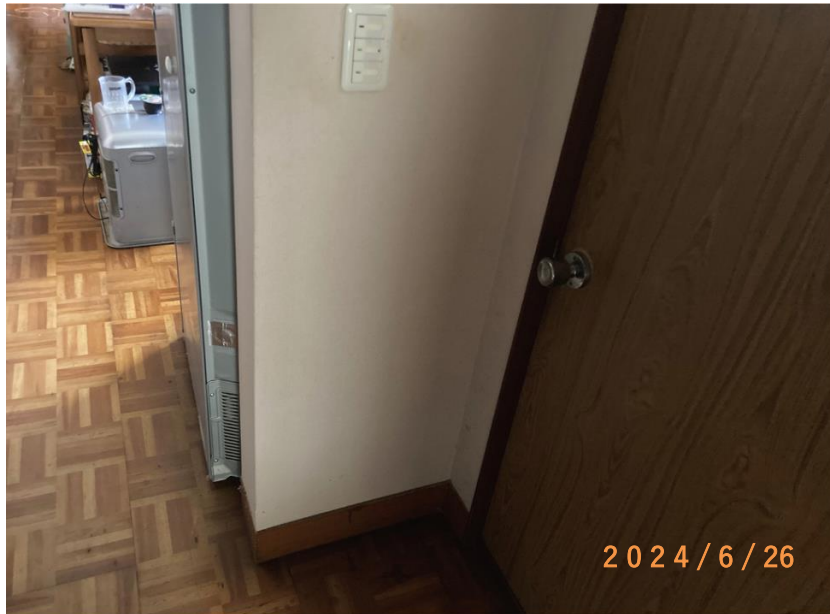
■現状写真■ (工事施工前)
