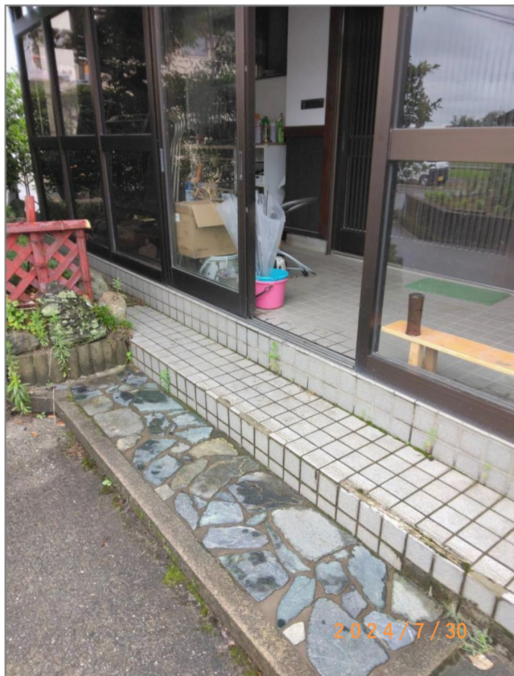
■現状写真■ (工事施工前)
