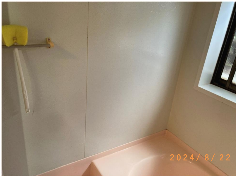
■現状写真■ (工事施工前)
