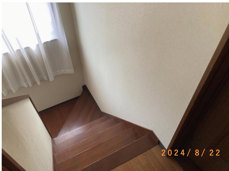
■現状写真■ (工事施工前)
