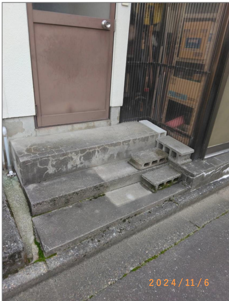
■現状写真■ (工事施工前)
