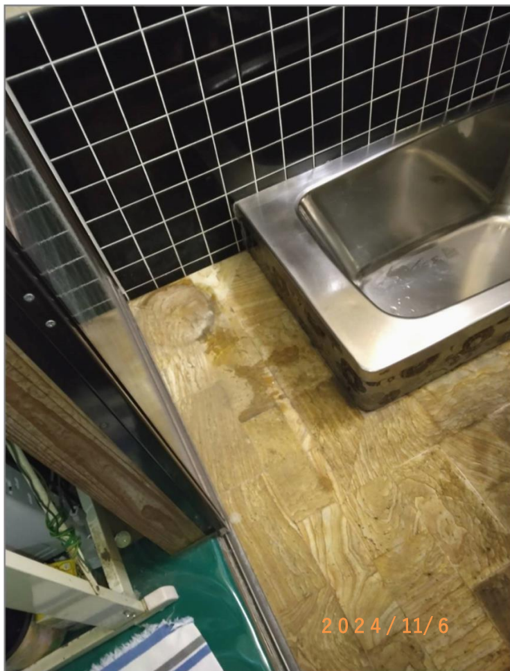
■現状写真■ (工事施工前)
