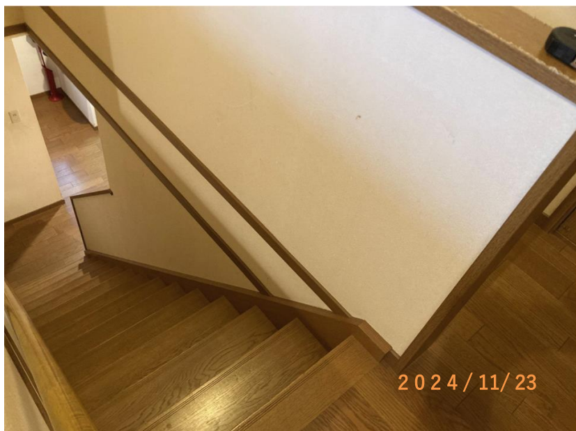
■現状写真■ (工事施工前)
