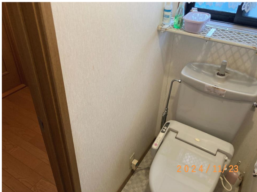
■現状写真■ (工事施工前)
