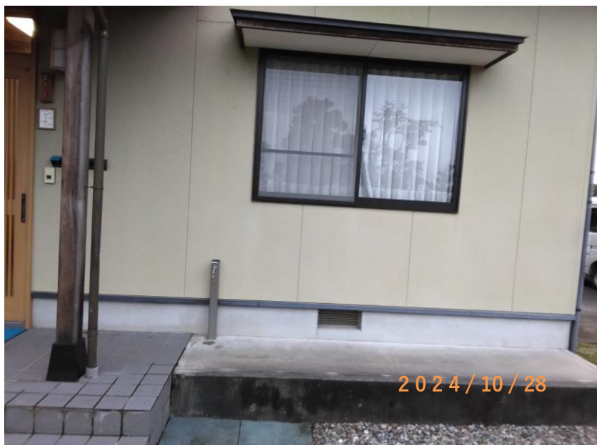
■現状写真■ (工事施工前)
