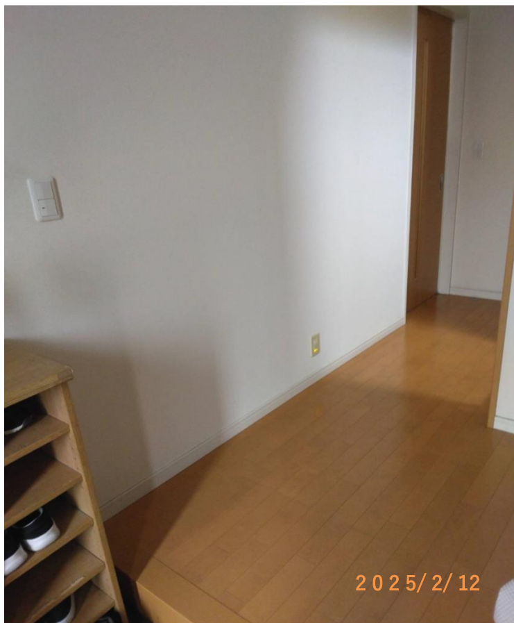
■現状写真■ (工事施工前)
