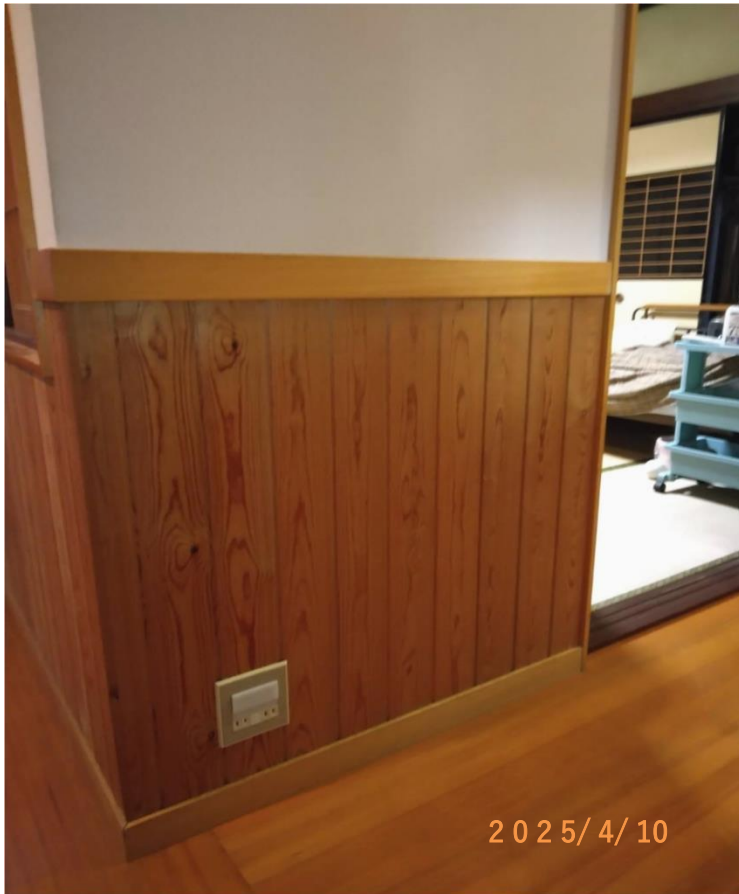
■現状写真■ (工事施工前)
