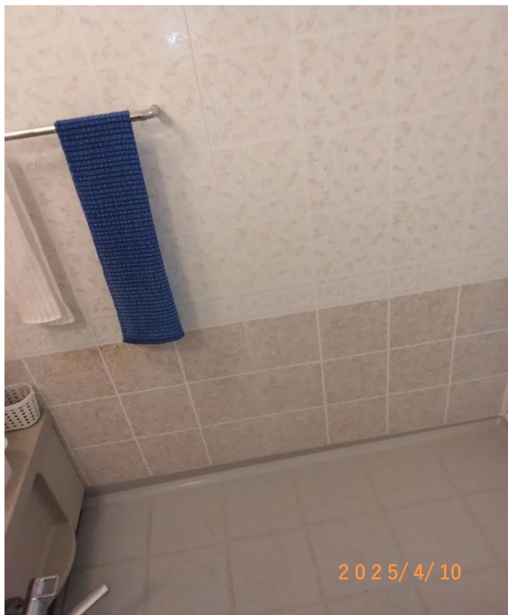
■現状写真■ (工事施工前)
