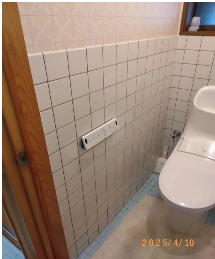
■現状写真■ (工事施工前)
