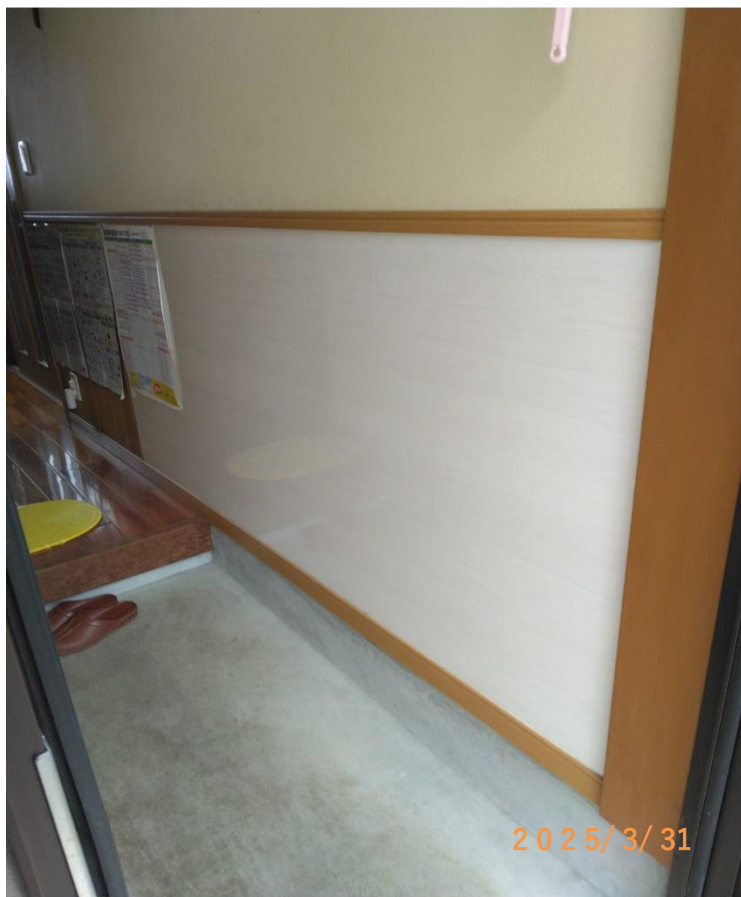
■現状写真■ (工事施工前)
