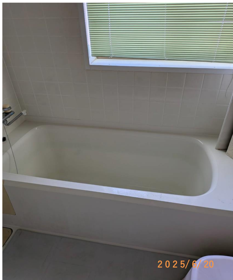
■現状写真■ (工事施工前)
