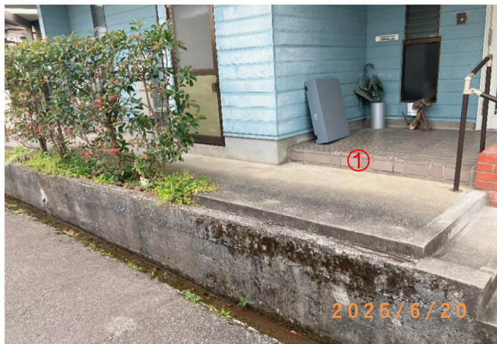
■現状写真■ (工事施工前)
