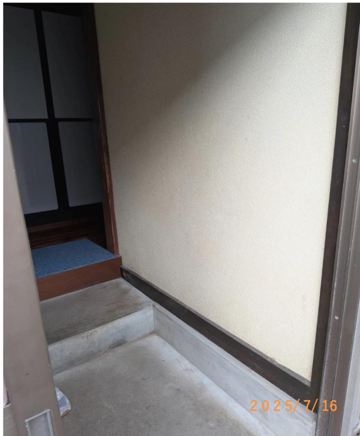
■現状写真■ (工事施工前)
