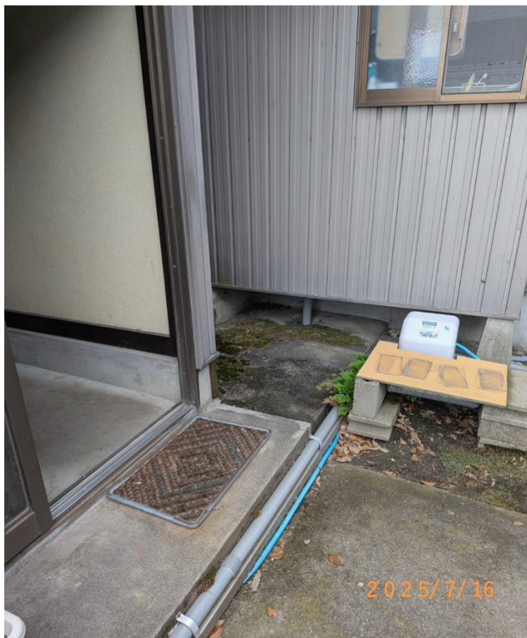
■現状写真■ (工事施工前)
