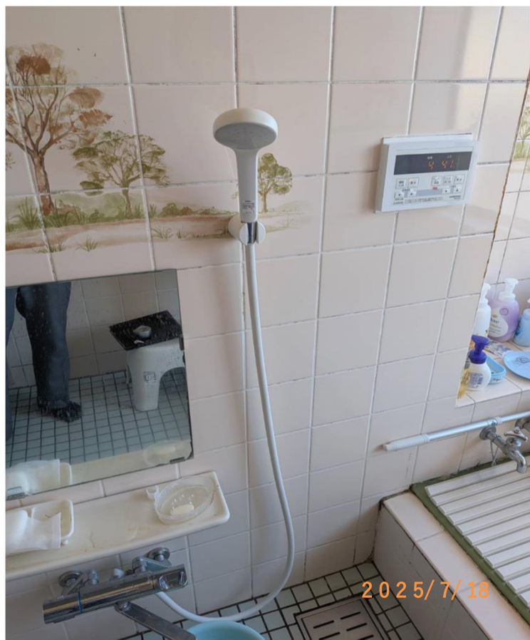
■現状写真■ (工事施工前)
