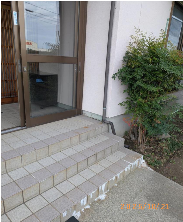
■現状写真■ (工事施工前)
