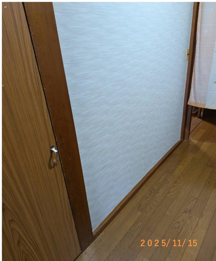
■現状写真■ (工事施工前)
