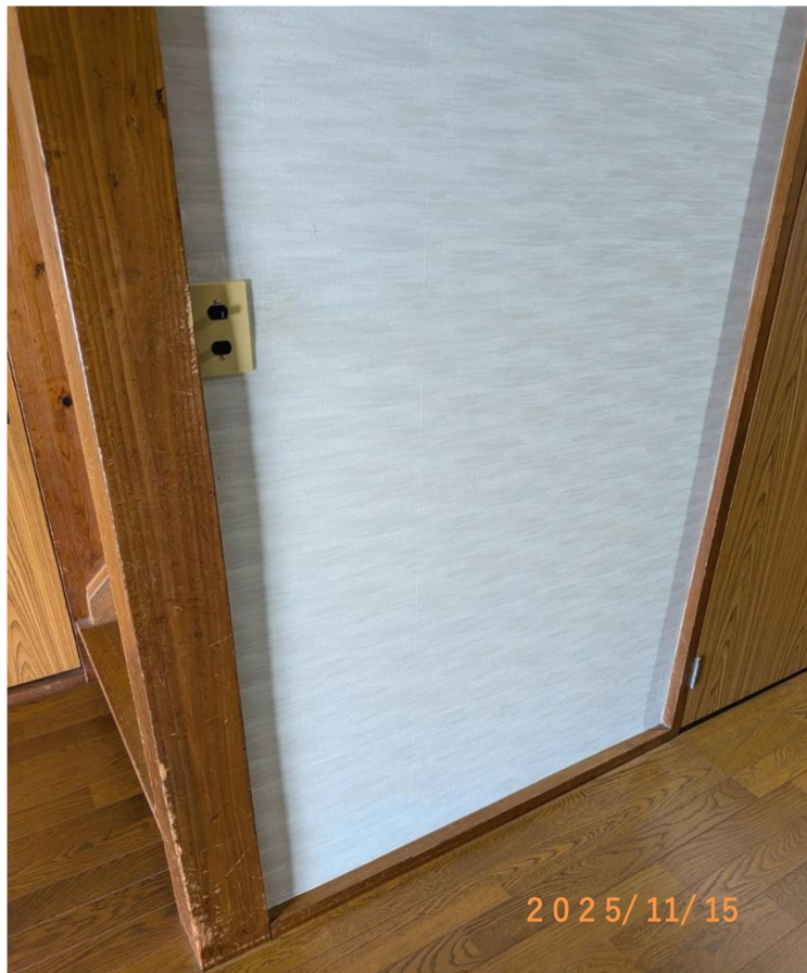
■現状写真■ (工事施工前)
