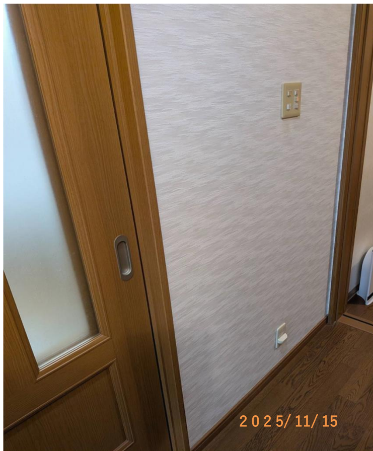
■現状写真■ (工事施工前)
