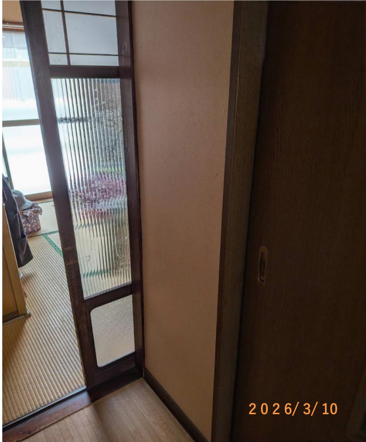
■現状写真■ (工事施工前)
