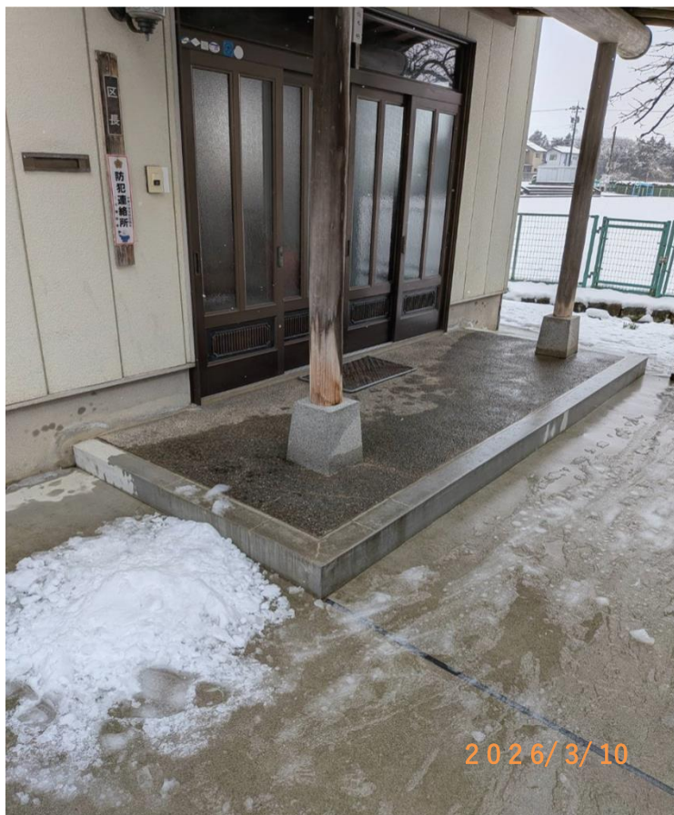
■現状写真■ (工事施工前)
