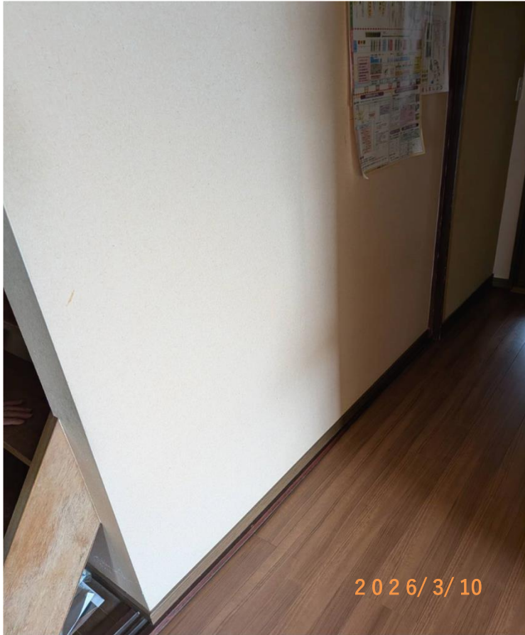
■現状写真■ (工事施工前)
