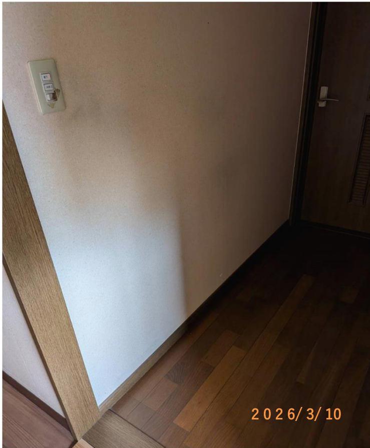
■現状写真■ (工事施工前)
