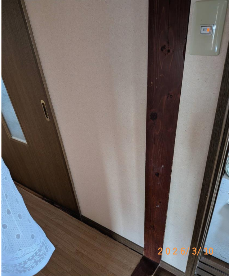
■現状写真■ (工事施工前)
