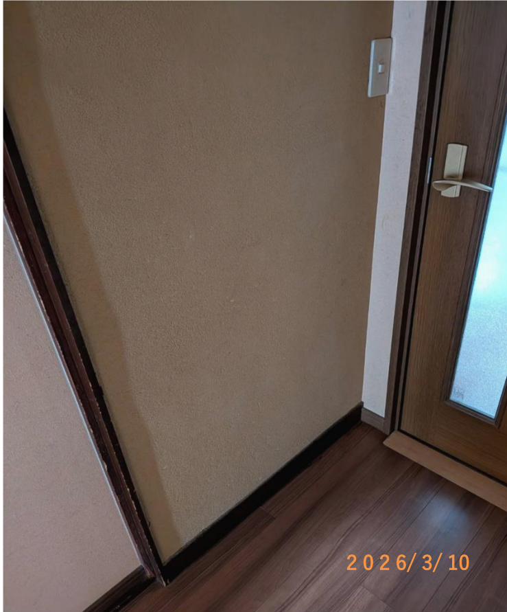
■現状写真■ (工事施工前)
