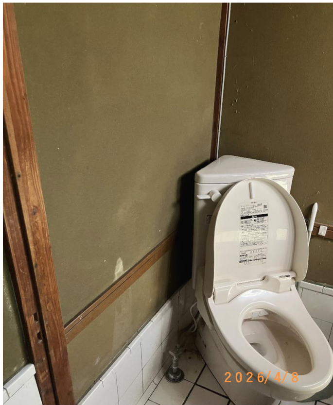
■現状写真■ (工事施工前)
