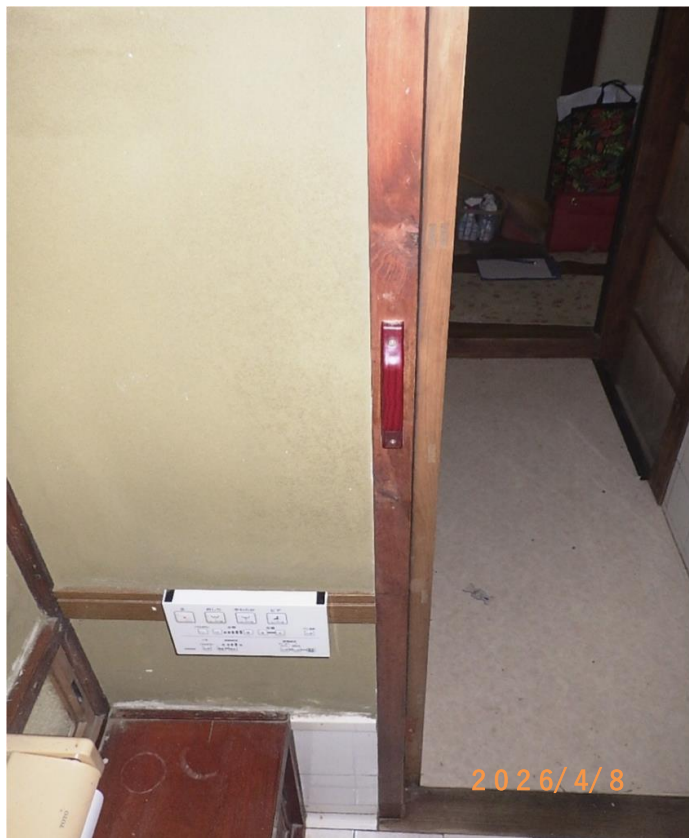
■現状写真■ (工事施工前)
