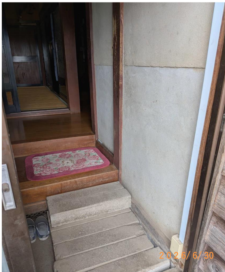
■現状写真■ (工事施工前)
